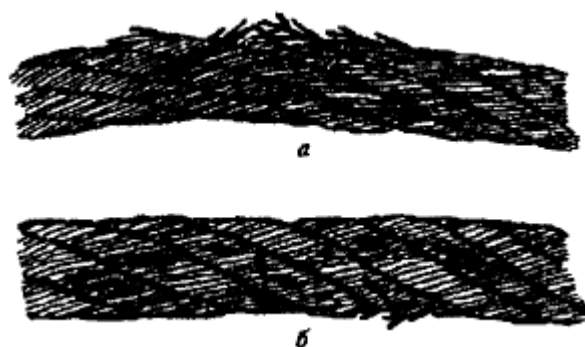
Рисунок 3. Обрывы проволок в зоне уравнительного блока:
